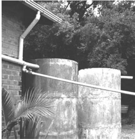
Figura 13: Cisterna para armazenar água da chuva
